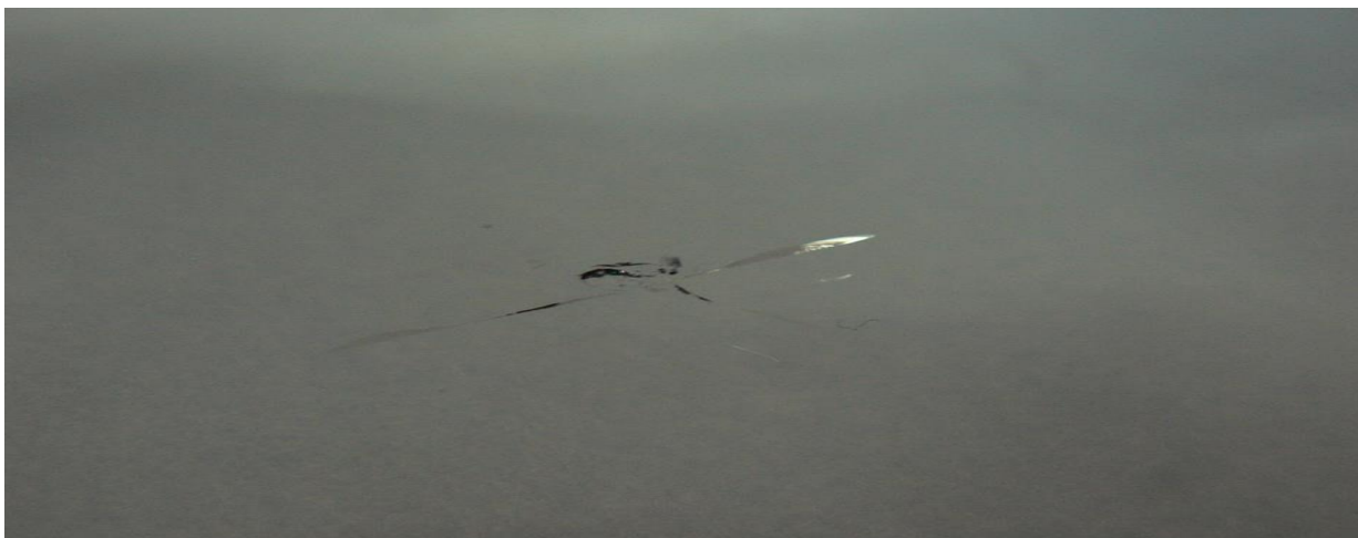
FOUT: Sterreparatie onvoldoende gevuld.
