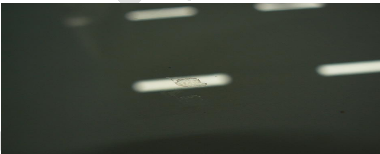
GOED: Sterreparatie voldoende gevuld en oppervlakte afgewerkt
