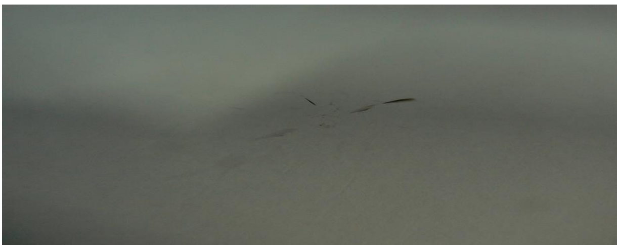
FOUT: Combinatiebreuk wel voldoende gevuld maar oppervlakte niet afgewerkt.
